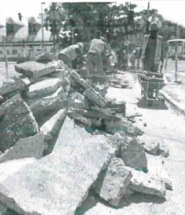
As obras da ciclovia da Avenida Bezerra de Menezes devem ser entregues em três meses
