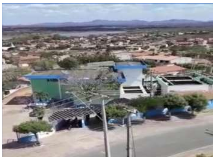
Figura 5 - Estação Antiga de Tratamento de Água - FSESP
