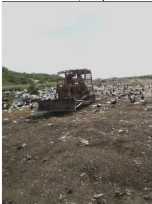
Figura 20 - Operação de aterramento e compactação dos resíduos no Lixão de Canindé
