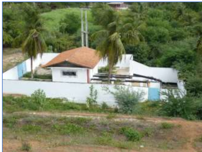
Figura 2 - Casa de bombas - Sistema de captação de água do Açude São Mateus
