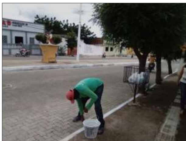
Figura 22 - Garis realizando pintura do meio fio após capinação e limpeza de sarjeta
