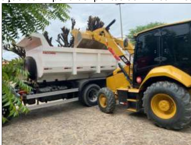
Figura 24 - Operação de limpeza de pontos de lixo com retirada de entulhos
