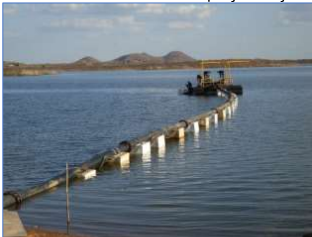
Figura 3 - Sistema flutuante de captação - Açude Sousa
